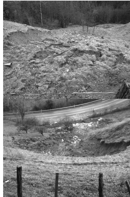
Fig. 1. Deslizamientos ocurridos en los municipios de Elgoibar (arriba) y Deba (abajo), afectando a zonas de prado y a carreteras.
