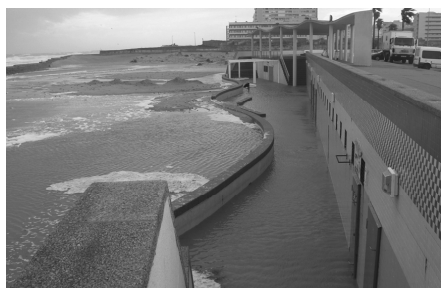
Fig. 4. Inundación de servicios de playa en la zona sur del área de estudio, durante un temporal con periodo de retorno inferior a 3 años, en Enero de 2010.
