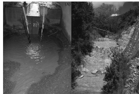
Fig. 1. A. Estación de aforo y canal de estiaje en la salida de la cuenca (Cárcavas). B. Sonda de nivel instalada a la salida de la zona forestal de la cuenca de Araguás (Repoblación).
