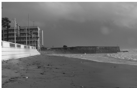
Fig. 3. Incidencia del oleaje sobre el paseo marítimo en el centro del área de estudio, durante un temporal con periodo de retorno inferior a 3 años, en Marzo de 2010.
